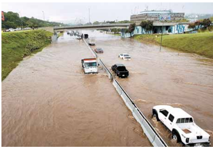
En la autopista Fajardo se formó una laguna que la hizo intransitable
