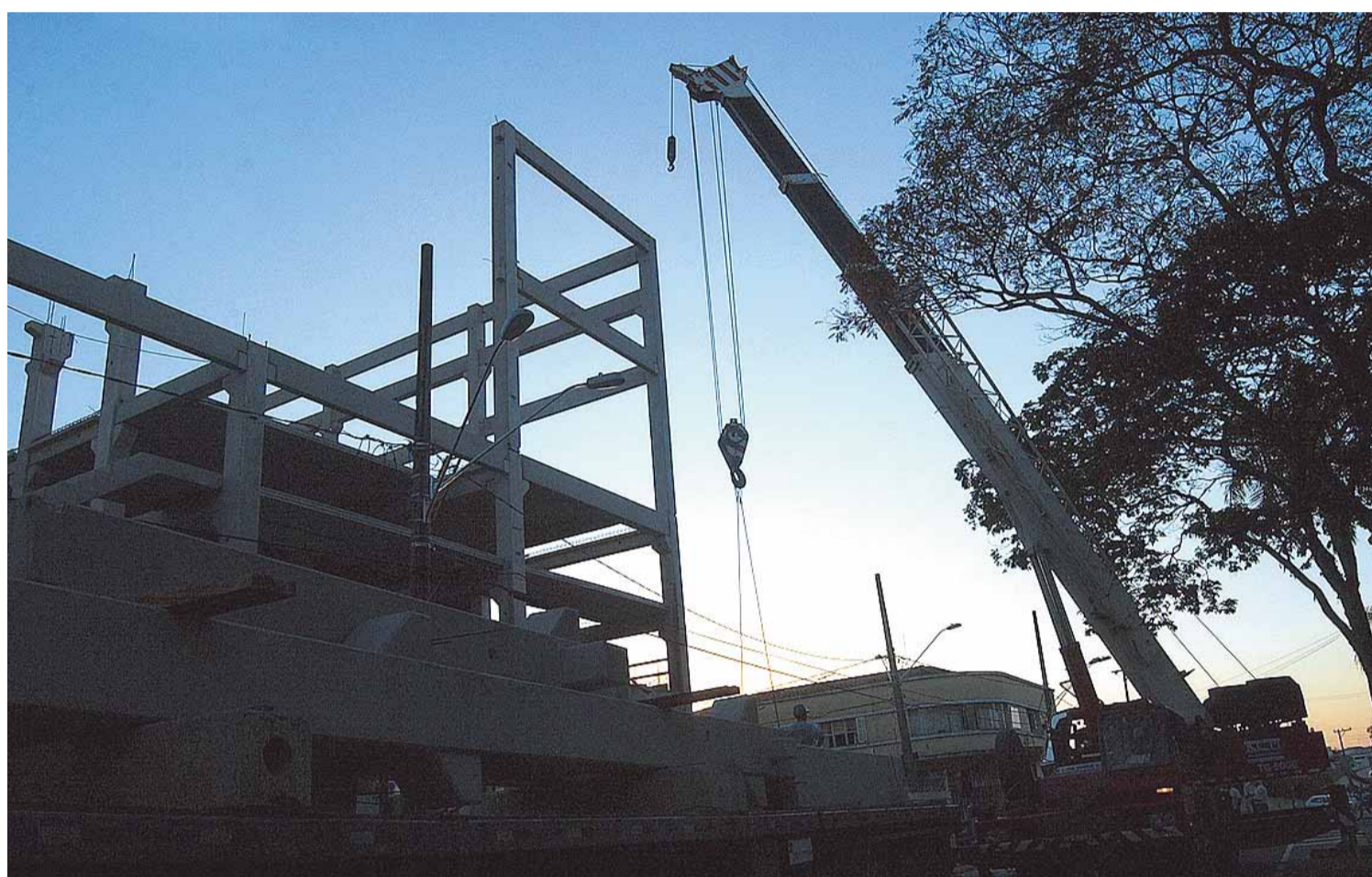
SANTA ROSÁLIA - A construção do Villaggio Shopping anima comerciantes e moradores de Santa Rosália. A obra deverá ficar pronta em abril de 2009 e o shopping terá 98 lojas e quatro salas de cinema. Ideal Borges Moreno, de 34 anos, já lucrou com a obra. Ele ganhou tijolos e com eles construiu a casa própria. Pág. B1
